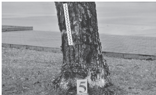
Uszkodzenia występujące na drzewie – po uderzeniu motocyklem
