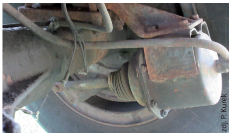
Fot. 4. Kontrola tłoczyśk siłowników.
