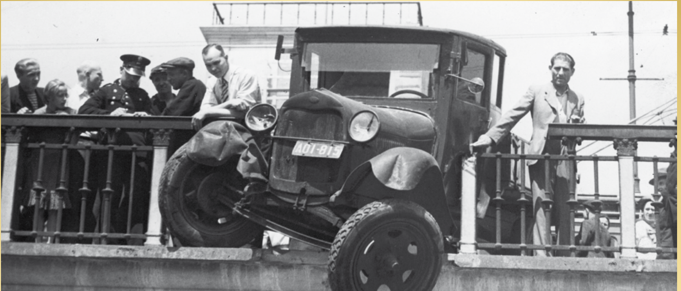
Samochód ciężarowy zawieszony na krawędzi wiaduktu Pancera po uderzeniu w barierkę na Nowym Zjeździe. Widoczni gapię oraz policjant spisujący zeznania świadków. Warszawa 7.07.1938 r. Źródło: NAC sygn. 1-G-3958-2.
