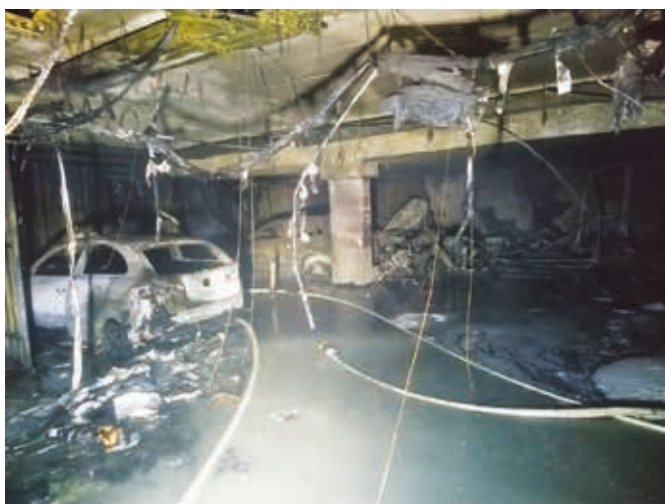
Fot. 3. Pożar samochodów na parkingu podziemnym.
