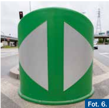
Ryc. 13. Przykład zastosowania osłony zabezpieczającej w postaci monobloku U-15b 20 .
