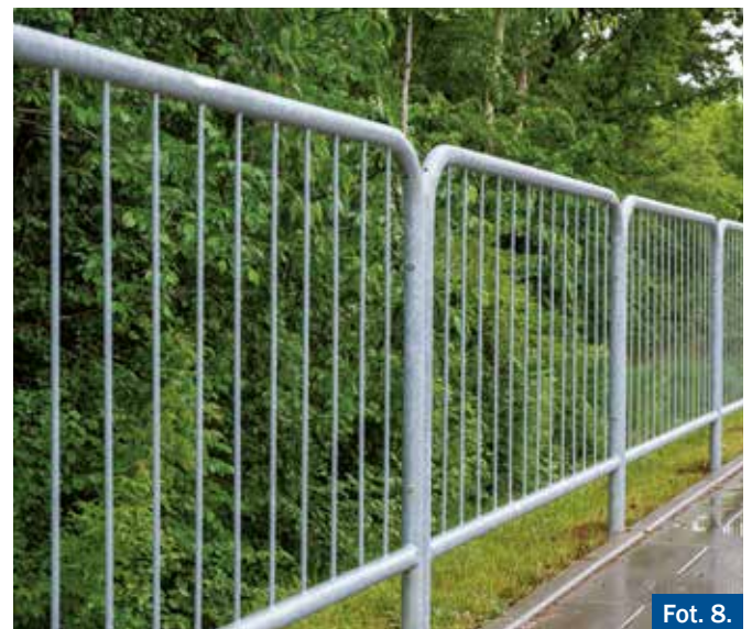
Fot. 8. Zastosowanie balustrady U-11a do zabezpieczenia przed upadkiem z nasypu.
