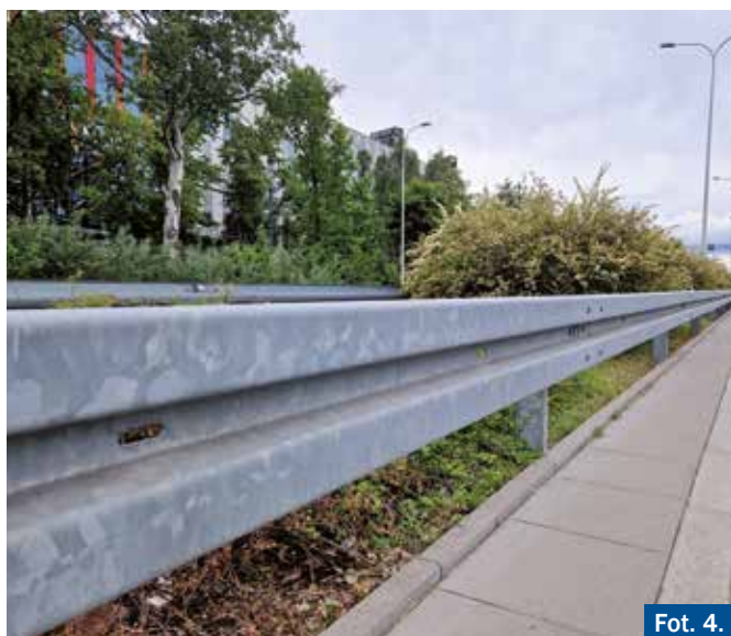
Fot. 4. Przykład zastosowania stalowej bariery ochronnej U-14a (dzielącej).
