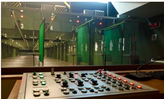
Strzelnica – widok na oś strzelecką z pomieszczenia sterowni
