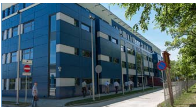
■ KMP Płock – budowa nowej siedziby stacji kontroli
