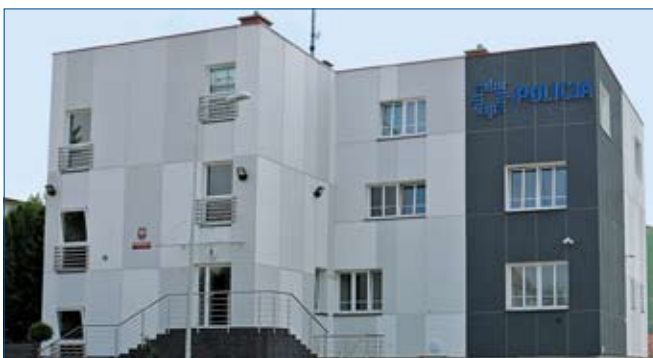
■ KPP Sępólno Krajeńskie – przebudowa i modernizacja siedziby przy ul. Tadeusza Kościuszki
