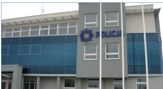
■ KPP w Opocznie – budowa nowej siedziby
