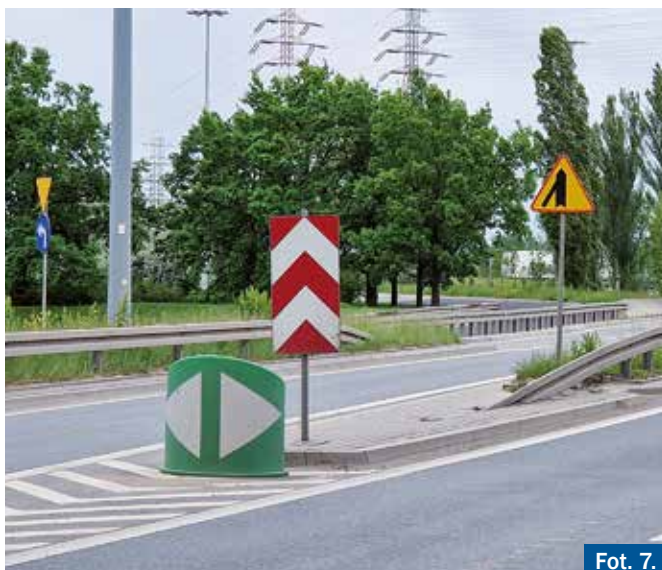
Fot. 7. Zastosowanie barier ochronnych U-14a, osłony zabezpieczającej w postaci monobloku U-15b oraz tablicy rozdzielającej U-4a.
