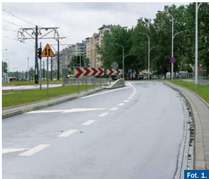
Fot. 1. Widok ogólny tablic prowadzących U-3a rozmieszczonych schodkowo w miejscu zanikania lewego pasa ruchu.
