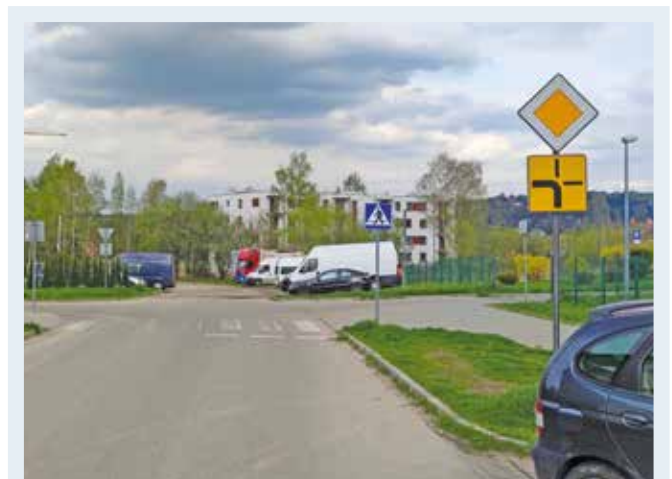
Fot. 1. Skrzyżowanie z oznakowaniem pionowym D-1 „droga z pierwszeństwem” i T-6a „tabliczka wskazująca rzeczywisty przebieg drogi z pierwszeństwem przez skrzyżowanie”.
