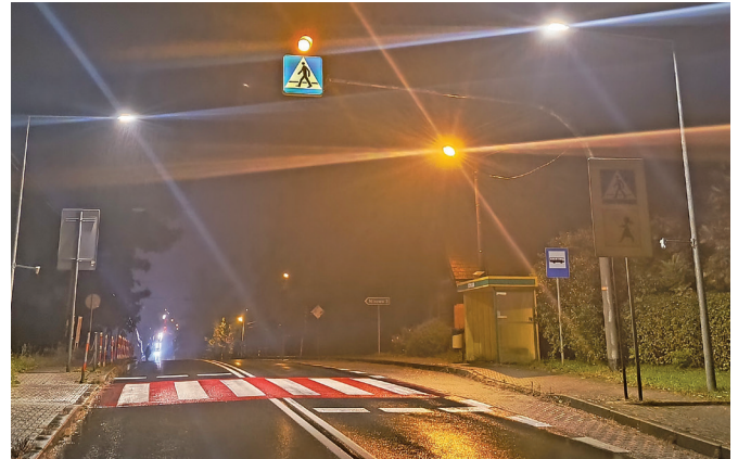
Fot. 2. DW 966 m. Bilczyce, przejście dla pieszych z dedykowanym oświetleniem. Zdj. W. Matras.
