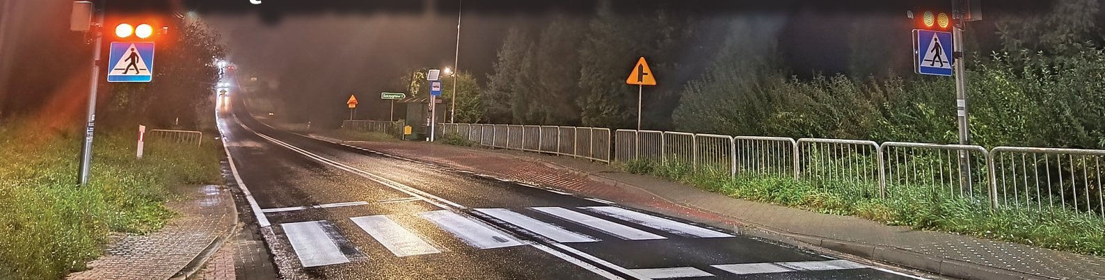
Fot. 1. DW 966 m. Biskupice, przejście dla pieszych z dedykowanym oświetleniem. Zdj. W. Matras.
