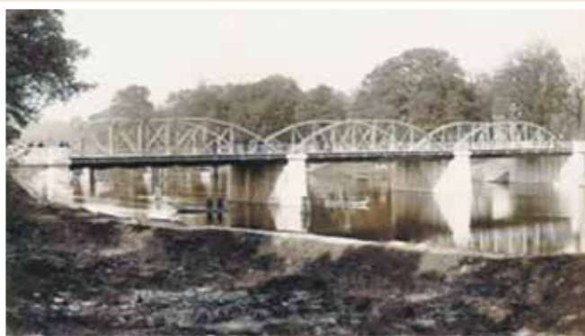
Fot. 2. Widok mostu na Odrze w Kędzierzynie-Koźlu przed jego zniszczeniem w 1945 r.
