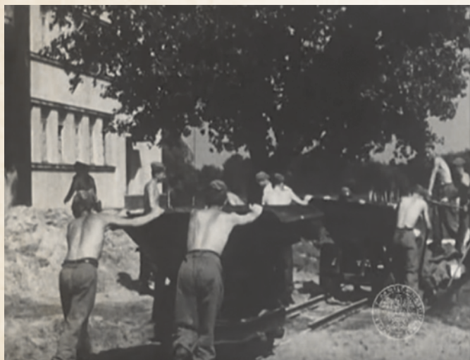
Fot. 3. Słuchacze podczas prac porządkowo-remontowych. Źródło: Kadr z IPN TV – „Z filmoteki bezpieki”, odc. 10. – „Historia szkoły w Legionowie”.
